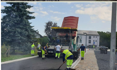
L'église rue de la Tannerie : pose de la couche de finition (Luxgreen et Socoetra)
