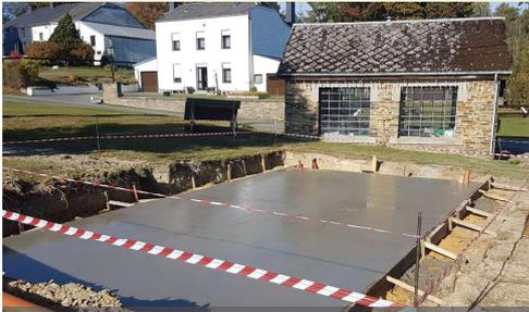
Chantier de notre équipe : terrassement et dalle béton pour l'installation d'un chalet à Habaru.
