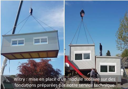
Witry : mise en place d'un module scolaire sur des fondations préparées par notre service technique
