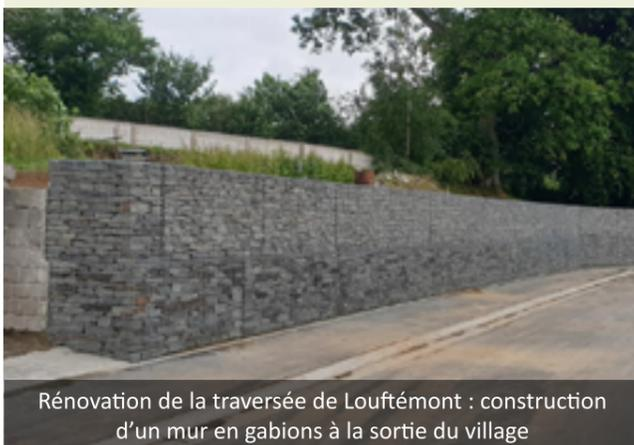
Rénovation de la traversée de Louftémont : construction d'un mur en gabions à la sortie du village
