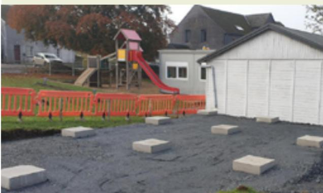
Les plots de béton coulés par notre équipe technique attendent les modules préfabriqués pour l'école de Witry
