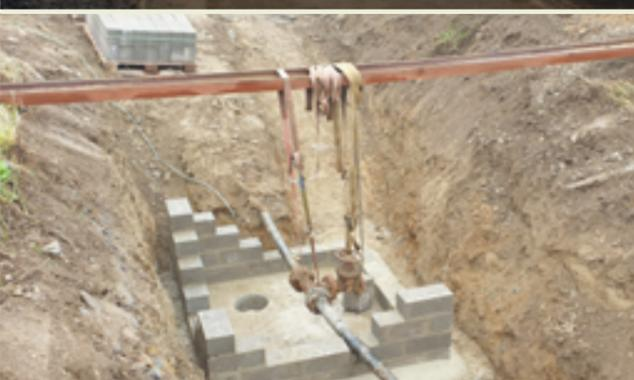
Distribution Witry-Volaiville : insertion d'un compteur dans une chambre pour aider à la détection de fuites
