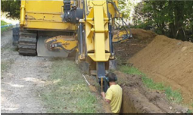
Chantier Wity - Louftémont : ouverture de la tranchée avec une trancheuse, c'est propre et rapide !
